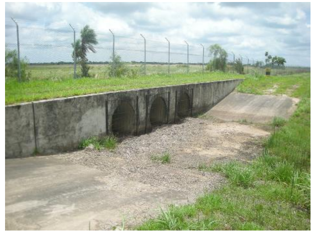
Obras de drenaje transversal mediante tubos.
