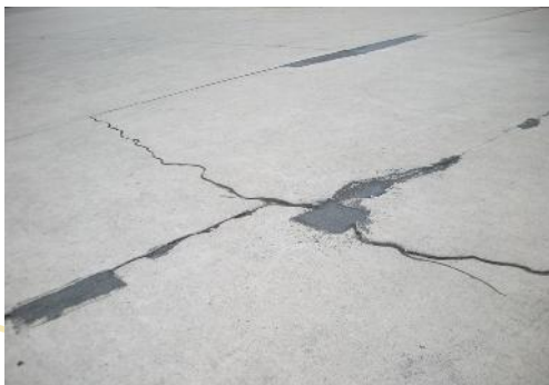
Despostillamientos y fisuras en la plataforma de estacionamiento de aeronaves.
