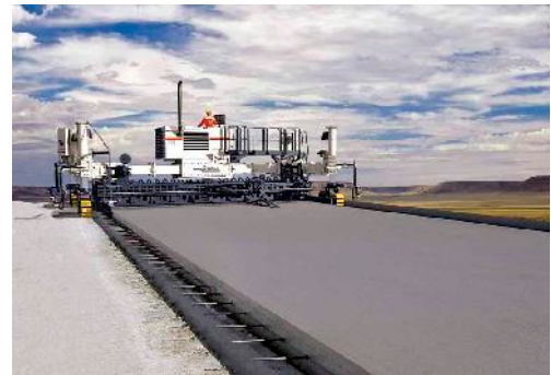
Colocación de pasadores.
