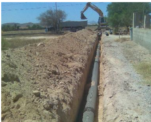
Red de alcantarillado.
