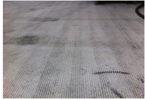
Pavimento pulido con discos de diamante.
