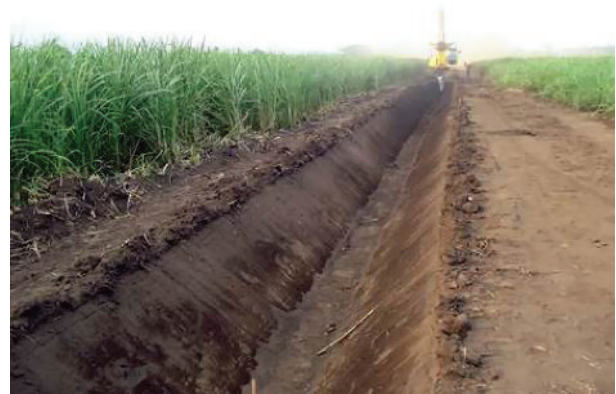
Canales de drenaje.
