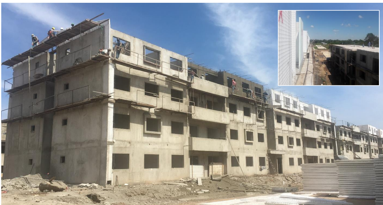
Proceso de construcción de Viviendas con paneles Emmedue (Condominios Altos de Cotoca)
