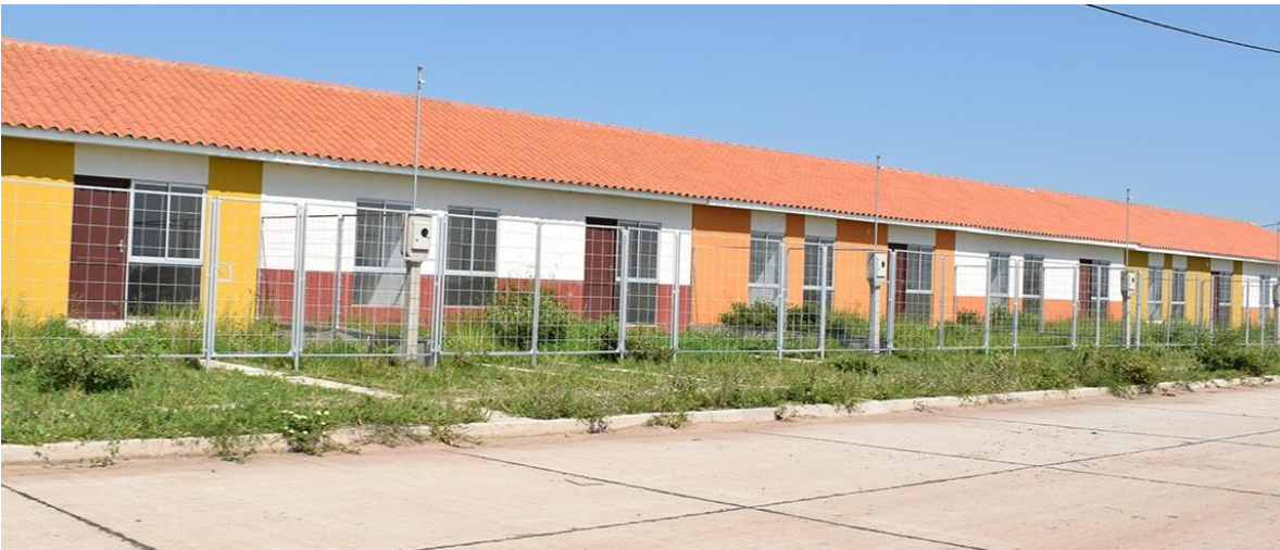
Vista Viviendas Urbanización Papa Francisco
