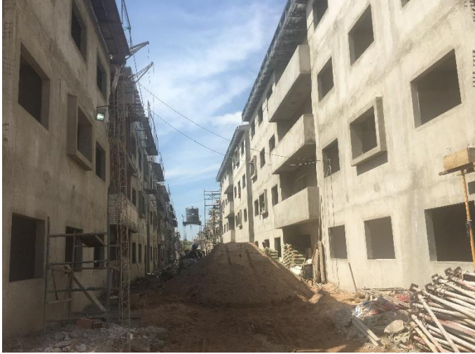
Vista ejecución de la estructura y bloques con el sistema M2
