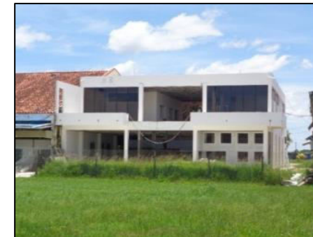
AMPLIACIÓN DE LA TERMINAL DE PASAJEROS, EN EJECUCIÓN
