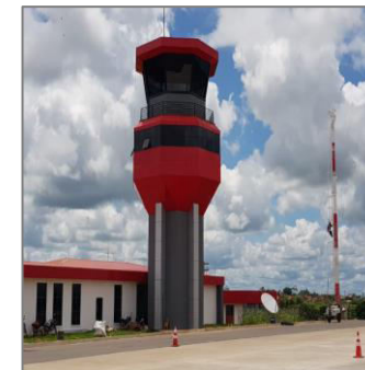
TORRE DE CONTROL
