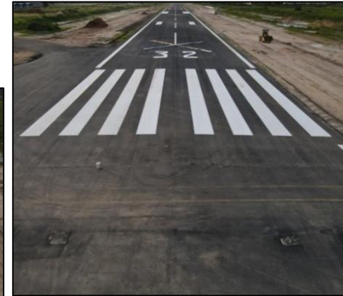
TRABAJOS DE PISTA, EN EJECUCIÓN
