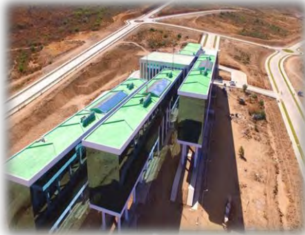
Edificio de plenarias: concluido con entrega provisional (abril 2016)
