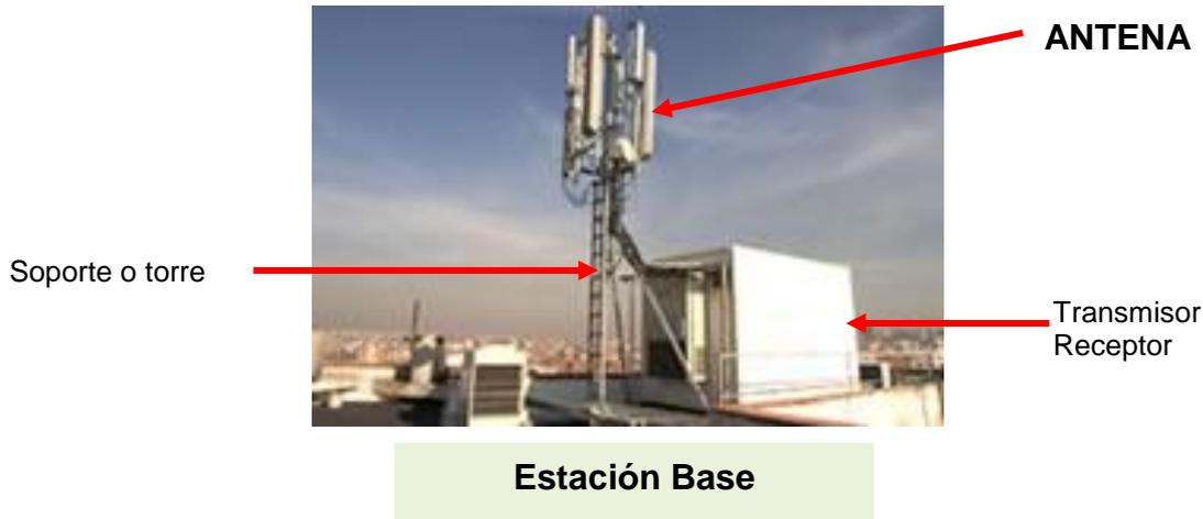
La antena emite un haz muy estrecho que se propaga casi de forma paralela al suelo y disminuye rápidamente al alejarse de ella. De modo que al nivel del suelo y en lugares de acceso público, las radiaciones electromagnéticas son muy inferiores a los niveles considerados peligrosos.
