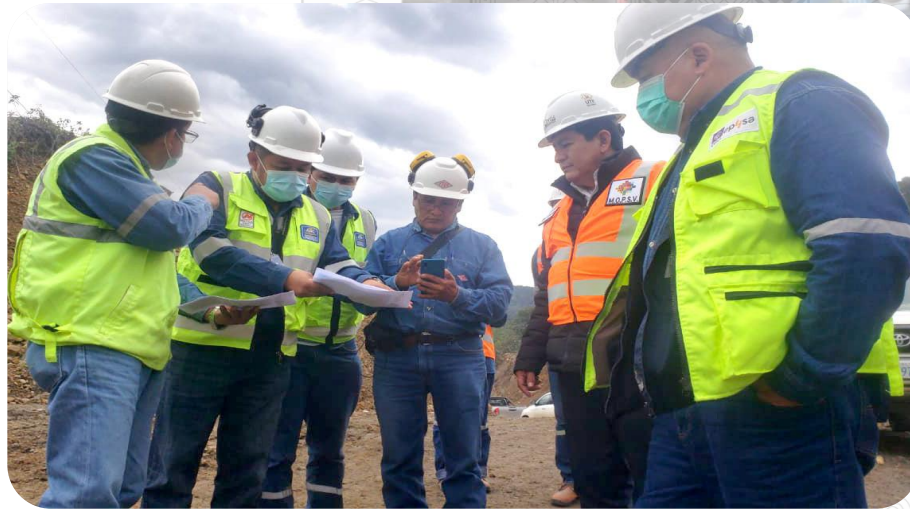
Inspección Tramo Central Doble Vía El Sillar
