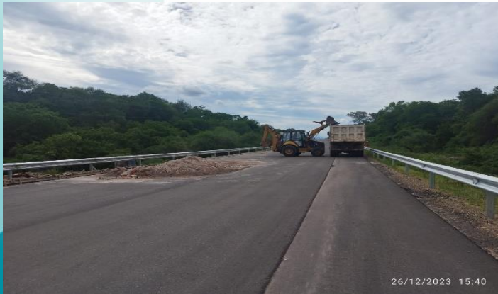
TRAMO CARRETERO VILLAMONTES – LA VERTIENTE – PALO MARCADO
