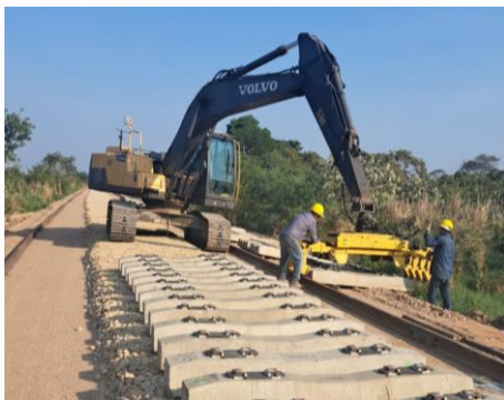
ARMADO DE COLLERA Y TROCHADO
