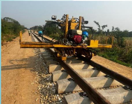
ARMADO DE COLLERA Y TROCHADO
