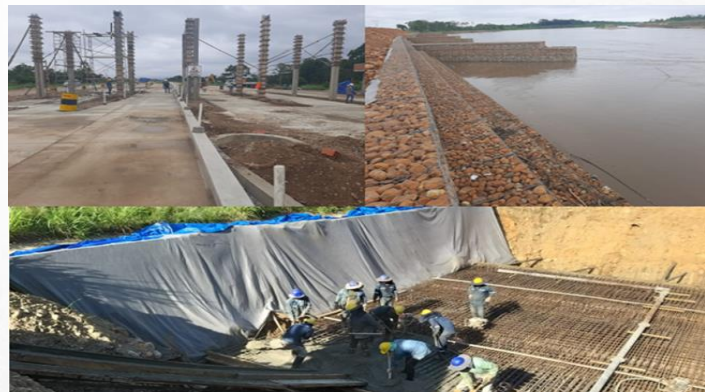
OBRAS COMPLEMENTARIAS TRAMO PUENTE YAPACANI - PUENTE ICHILO
