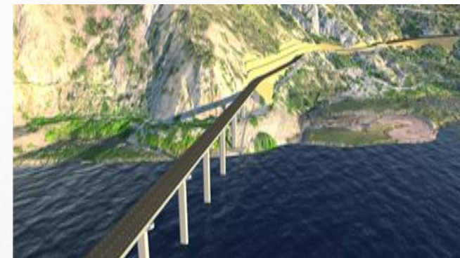
PUENTE SACAMBAYA Y SUS ACCESOS
