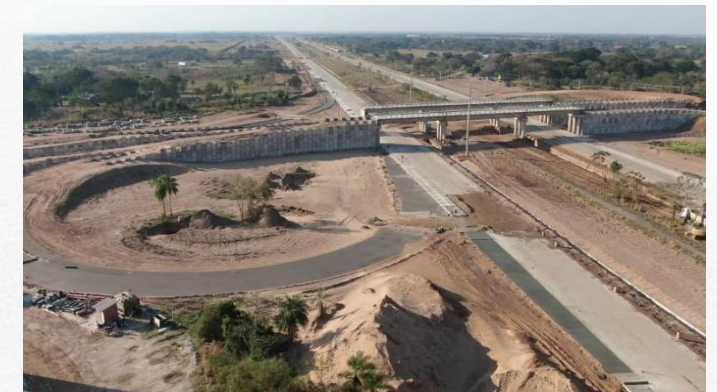
DOBLE VÍA SANTA CRUZ – WARNES (LADO ESTE)
