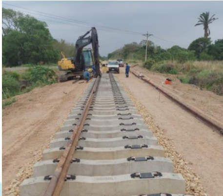
PERFILADO DE BALASTO
