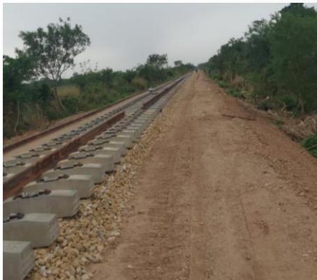
BALASTO Y LÍNEA FERROVIARIA
