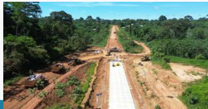
CONST. CARRETERA PUERTO RICO - EL SENA
