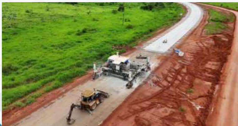
CONSTRUCCIÓN DE LA CARRETERA PORVENIR - PUERTO RICO - TRAMO IA: PORVENIR - SAN MIGUEL
