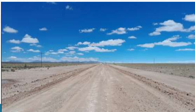
CONSTRUCCIÓN DE LA CARRETERA UYUNI-HITO LX TRAMOS 1 AL 3
