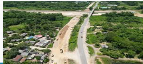
DOBLE VÍA VILLA TUNARI – PUENTE CHIMORÉ; TRAMO IV-A-2
