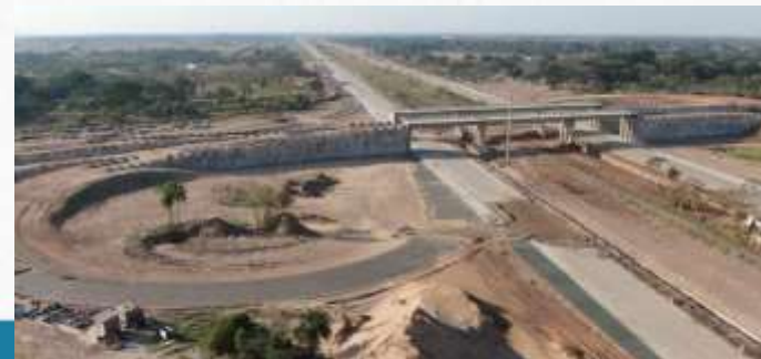
DOBLE VÍA SANTA CRUZ – WARNES (LADO ESTE)
