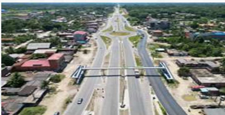
DOBLE VÍA PTE CHIMORÉ – VILLA TUNARI; TRAMO IV-A-1, FASE-I
