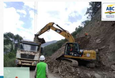
CONSTRUCCIÓN DE LA CARRETERA UNDUAVI CHULUMANI (EJECUCIÓN TRAMOS 2A Y 2B)
