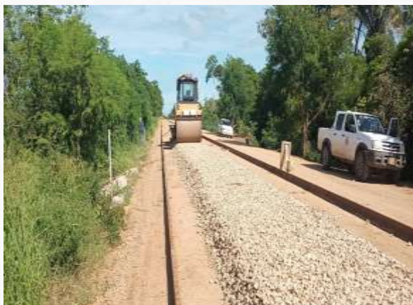
NIVELACIÓN DE BALASTO EN VIA FÉRREA
